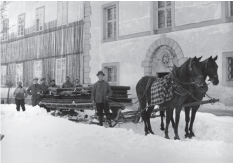
Abb. 29: Einbau der Zentralheizung 1925: Arbeiter mit den Radiatoren, welche in den Räumen des Klosters eingebaut wurden (Foto: Lienhardt, Einsiedeln).
