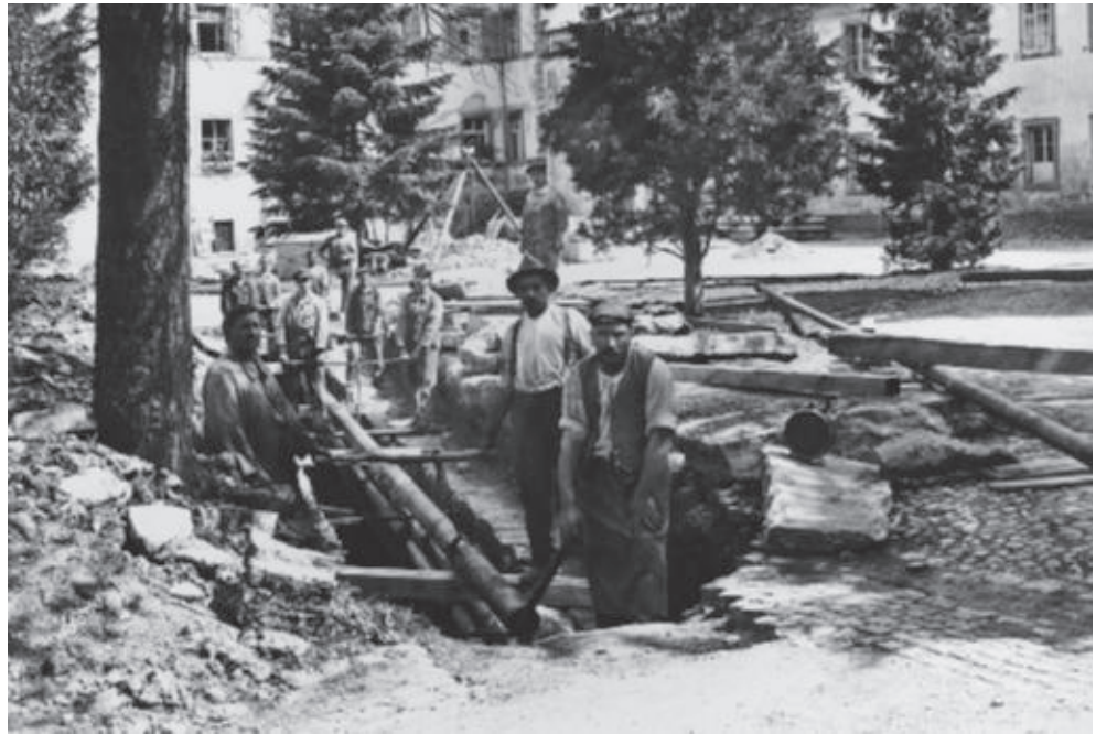
Abb. 28: Einbau der Zentralheizung 1925: Arbeiter bei der Aushebung eines Grabens im Klosterhof.
